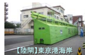
【陸閘】東京港海岸
