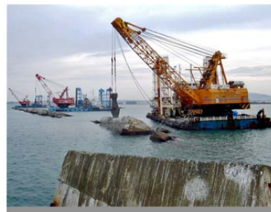
八戸港北防波堤
