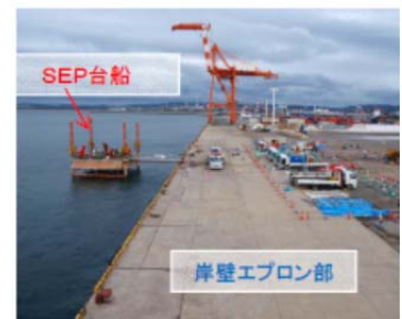
和歌山下津港本港地区 耐震岸壁改良状況
