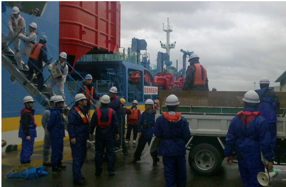
荷下ろしの状況①
