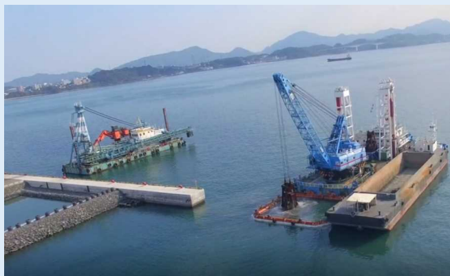
工事着工状況（岸壁前面の床掘）
