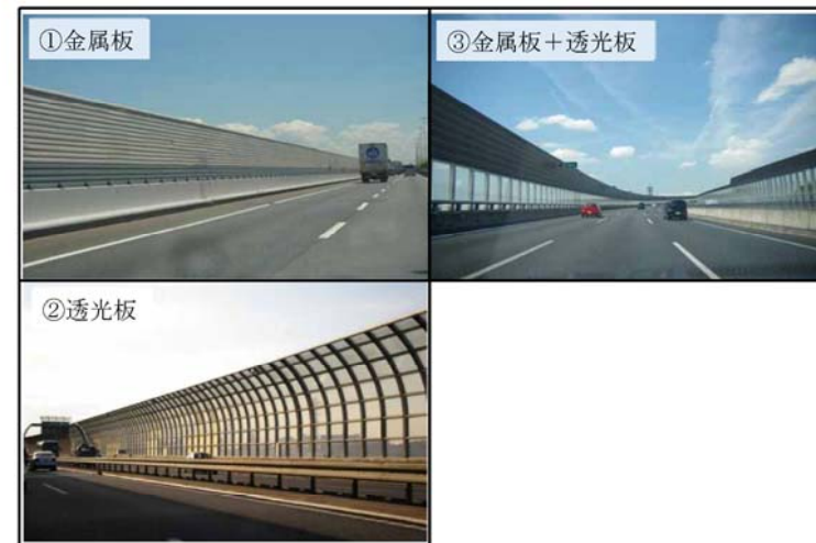
図 6. 3. 2-26 防音壁の材質
