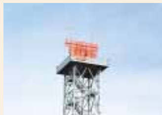
ターミナルレーダー施設(ASR/SSR)
