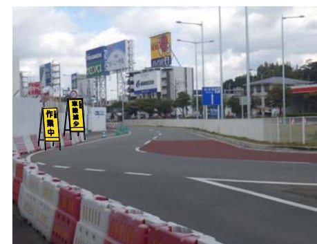
車線減少及び作業中看板
