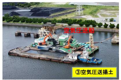
土運船で運搬した海底土砂を空気圧送船により、陸上に揚土します。
