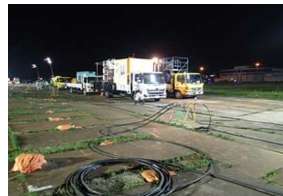
薬液注入状況
