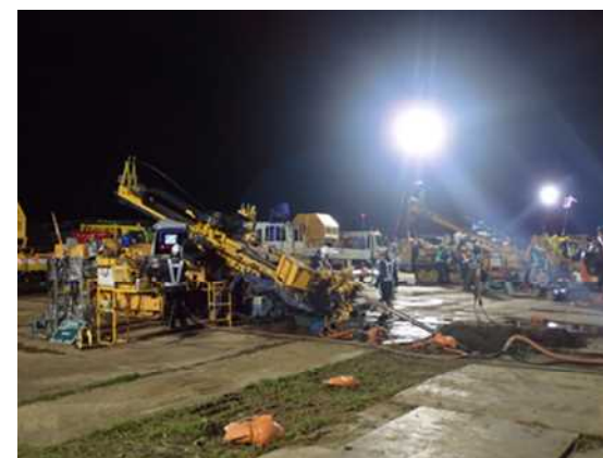
曲がり削孔状況
