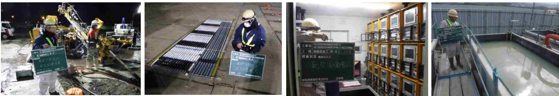
第三者による施工確認状況
