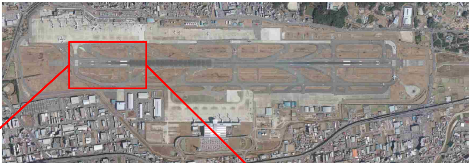
福岡空港における修補工事の対象箇所
