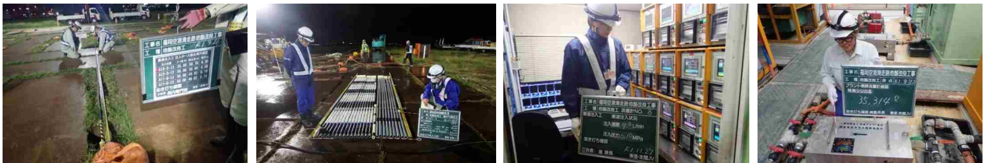
当局による抜き打ち施工確認状況
