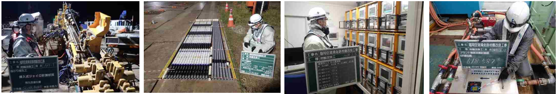
当局監督による施工確認状況
