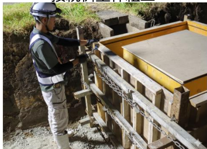
はいすいこう せつぞくます だせつ ⑫排水工(接続柵コンクリート打設)
