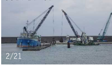
裏込石投入状況
