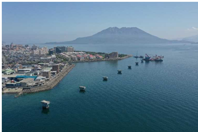
施工場所(6径間に鋼桁架設)
