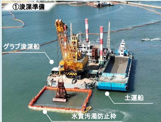
Grab浚渫船に土運船を接舷し、浚渫作業を行います。また、水質汚濁防止柵を設置することで、周辺への汚濁水の流出を防止しています。
