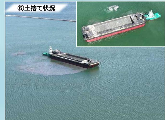
本工事にて使用している土運船は開閉式土運船を採用しており、船底が開閉できることで積込んだ土砂を一気に海中に投入することができます。
