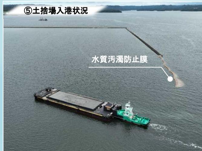
伊万里港浦ノ崎地区の土捨場に入港し、現況水深を確認しながら土捨て位置へ向かいます。土捨場には周辺海域への濁水流出防止のため水質汚濁防止膜を設置しています。
