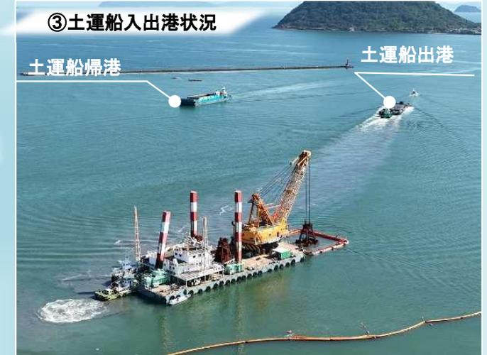
積込完了後、土運船は伊万里港浦ノ崎地区の土捨場に向け出港します。運搬時間は運搬形態によりますが、片道4時間～7時間の長距離運搬となります。
