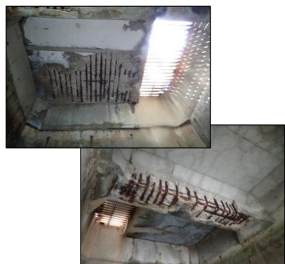
老朽化により腐食した岸壁内部
