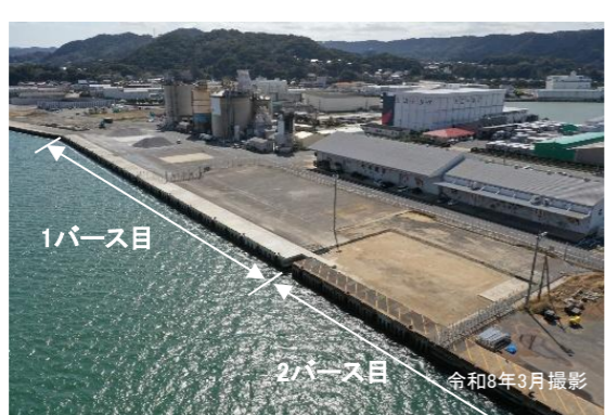
岸壁(-7.5m)(改良) 2バース目整備中 (1バース目施工完了)
