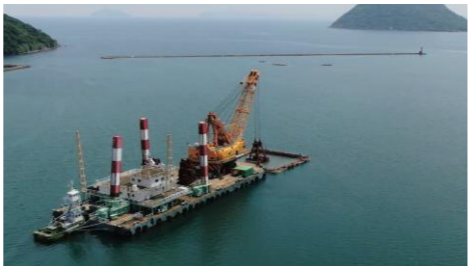
航路泊地(-9m) 整備中
