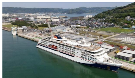
岸壁(-9m)(耐震) 平成28年4月暫定供用開始
