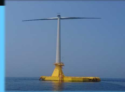
令和元年5月21日より北九州市響灘沖で実証運転を始めた浮体式洋上風力発電システム 令和元年7月1日撮影
