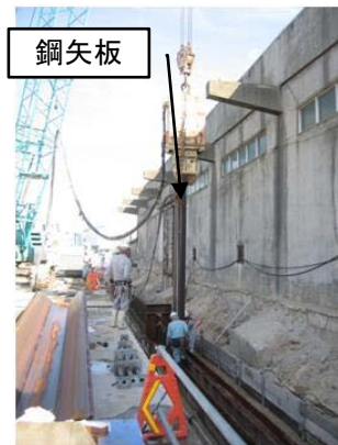
鋼矢板打込の様子
