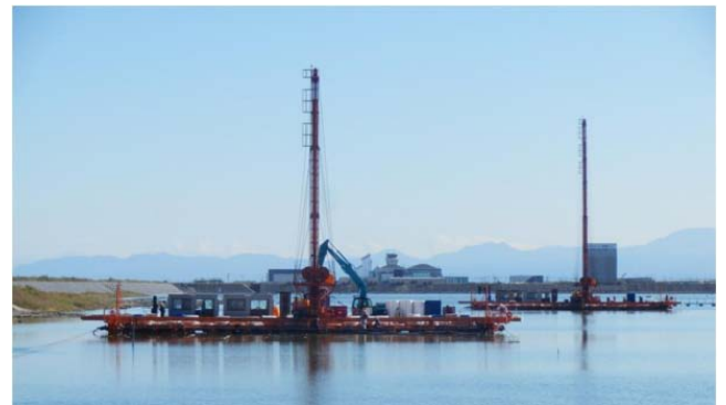
PDF船によるプラスチックボードドレーンの打設状況
