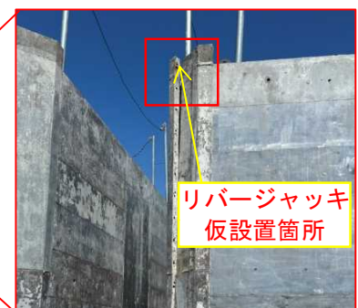
内型枠解体・切替作業箇所
