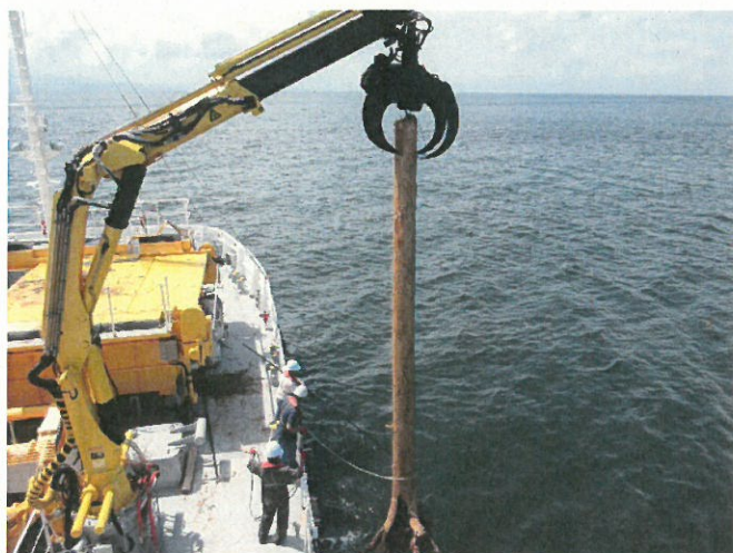
海煌による多関節クレーンを使用した流木の回収 （7月7日、多比良沖にて）
