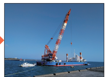
ブロック据付
