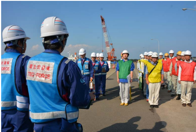
港湾施設点検班長から班員へ岸壁の点検指示状況
