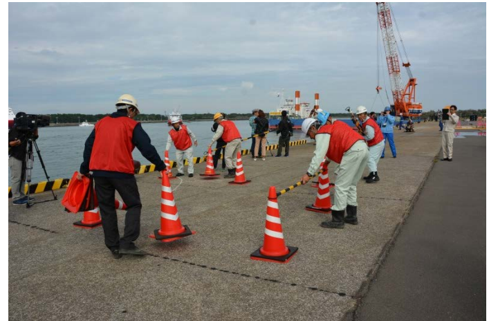
岸壁の危険箇所に立入禁止バリケードを設置中
