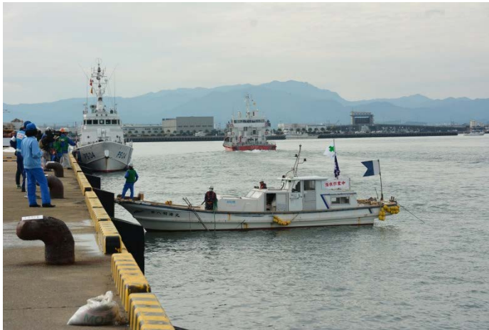
岸壁(水中部)の土台や本体に損傷がないか潜水士により点検中
