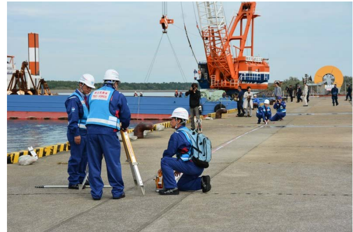
岸壁が海側に倒れ込みがないか測量中
