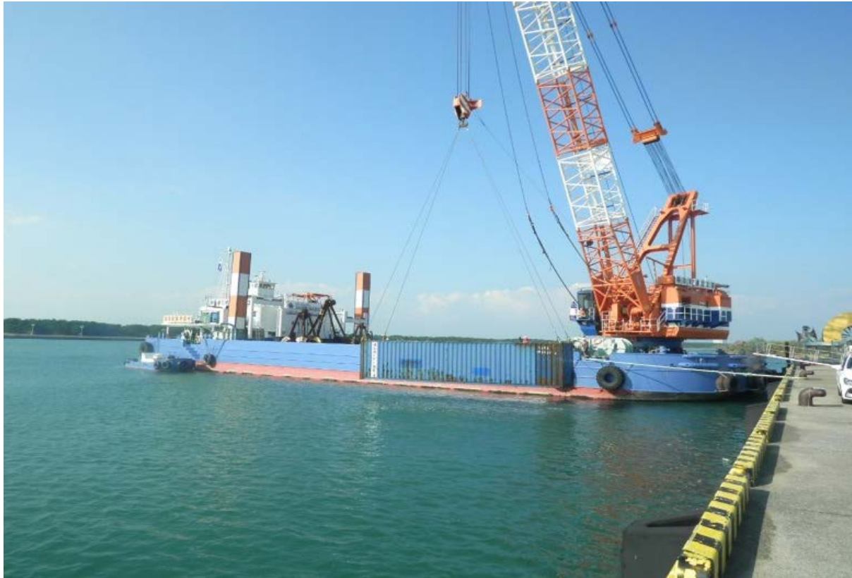
災害協定団体所有船「第八幸洋」による沈降物引き揚げ状況
