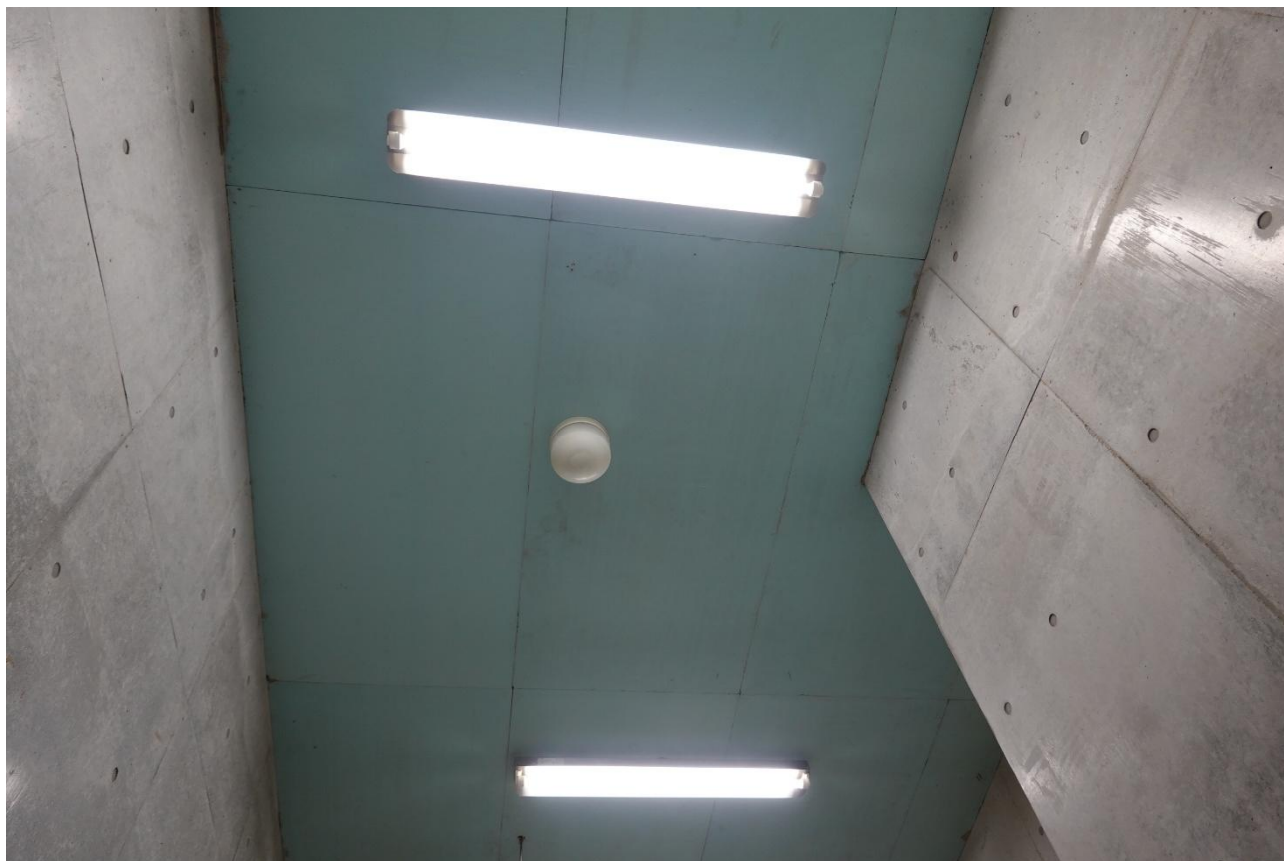
写真 燃料タンク室（1本タイプ）2台
