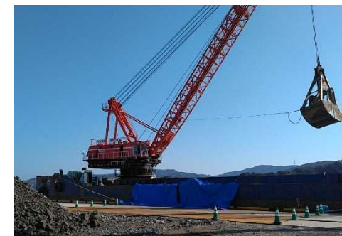
③ 起重機船揚土
