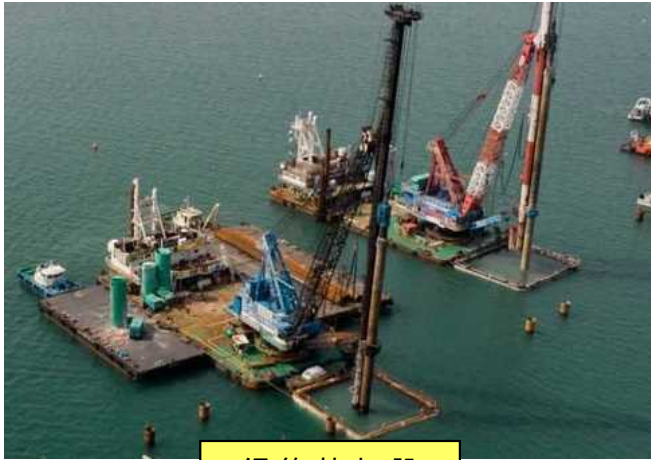
鋼管杭打設
