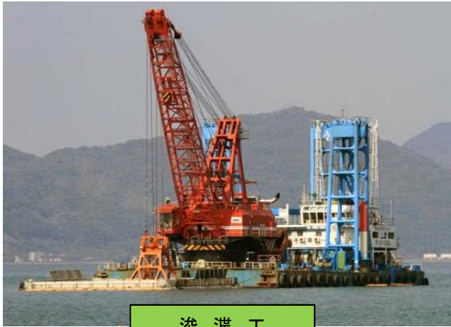
鋼管杭打設
