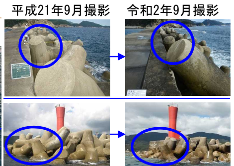
消波ブロック飛散・沈下状況
