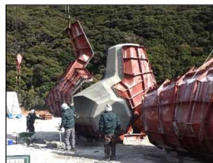
③型枠取り外し
