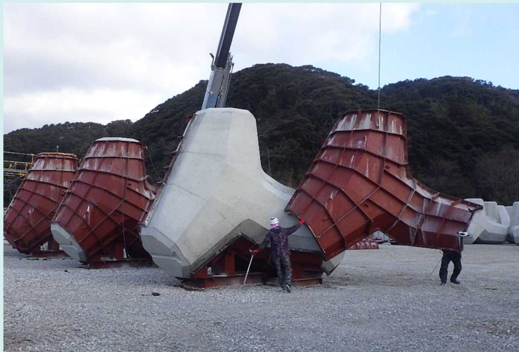
厳原港防波堤(北)改良工事施工状況(脱枠)
