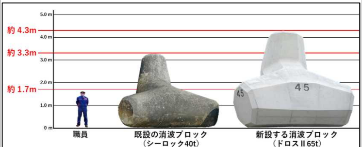
既設の消波ブロックと新設する消波ブロックの比較
