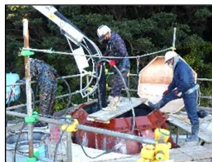
②コンクリート打設
