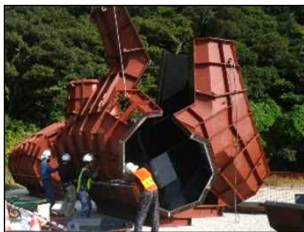
①型枠組立
