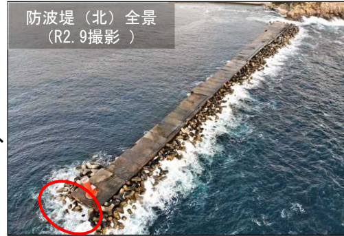
防波堤(北)の現状
