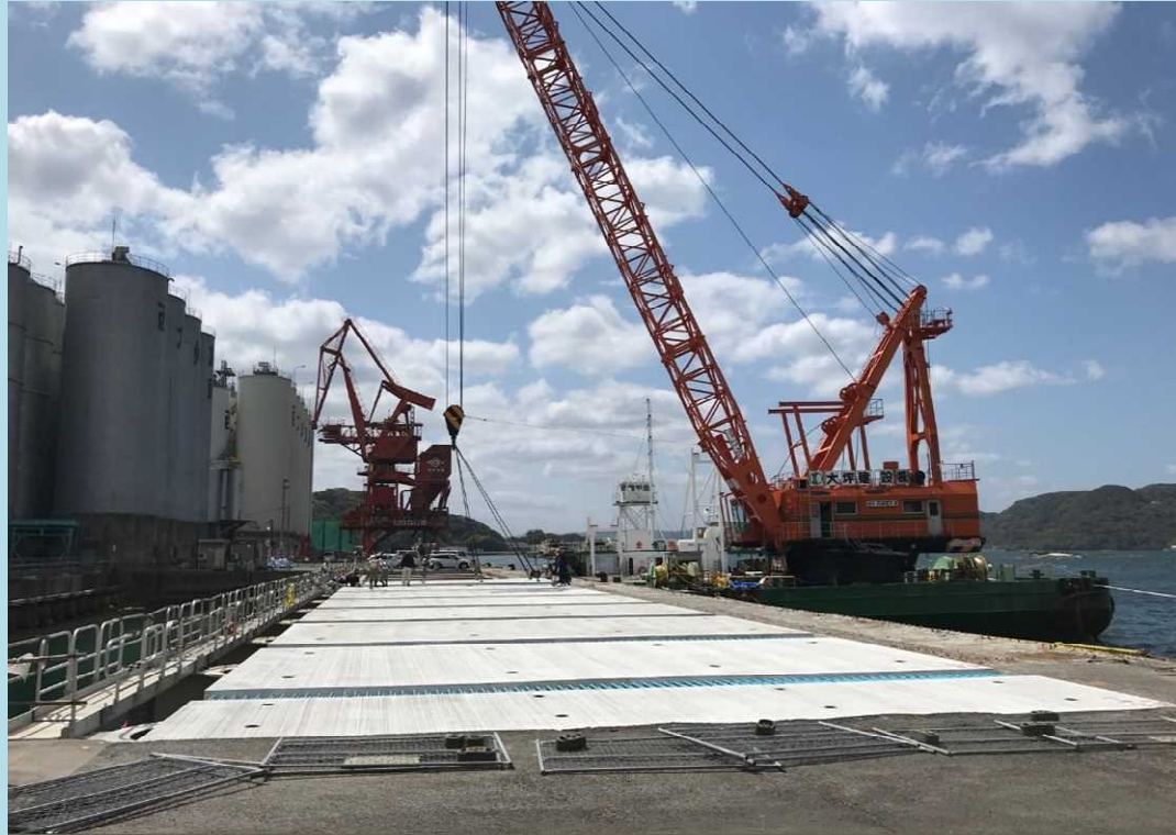
佐世保港前畑地区岸壁(-10m)床版据付工事状況
