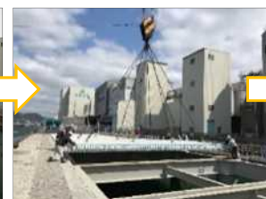
⑤床版据付
