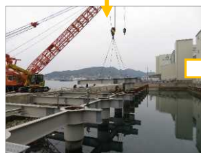
④上部桁設置
