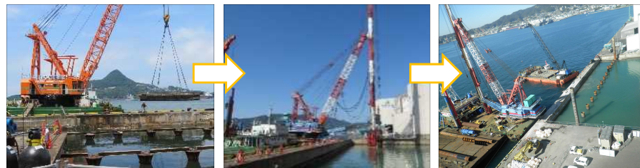
①既設床版・鋼管杭撤去
