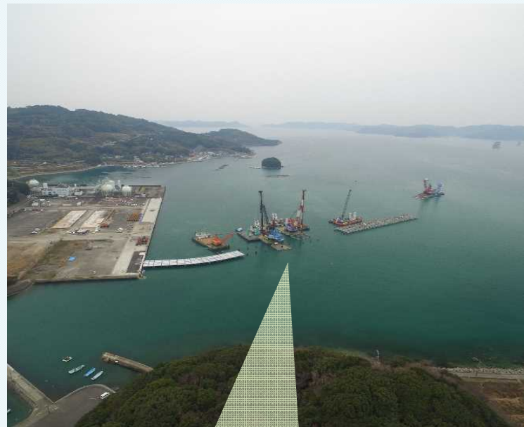
5-②. 鋼管杭打設状況
