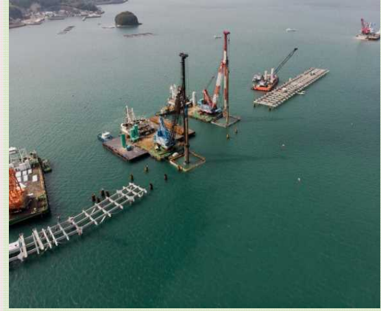
5-②. 鋼管杭打設状況
