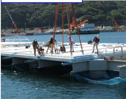
250t吊の起重機船を使用し、床版の据付を行っています。9月いっぱいまで据付が完了する予定です。
