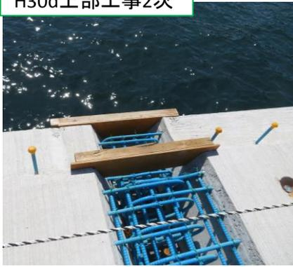
9/13に床版の据付が完了しました。現在、床版の間詰コンクリートを打設するため、型枠準備等を行っています。
