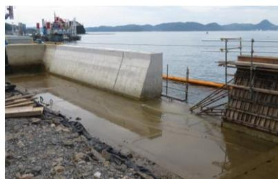
国際クルーズ拠点整備事業に併せて、既存の-7.5m岸壁改良工事(上部コンクリート打ちかえ)を行っています。取り壊しは全て終わり、現在コンクリート打設が半分以上完了しました。打設後は背後に雑石等を埋め戻し、舗装します。
