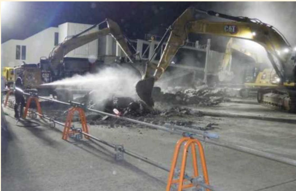
長崎空港エプロン改良工事施工状況(舗装版取壊し)
