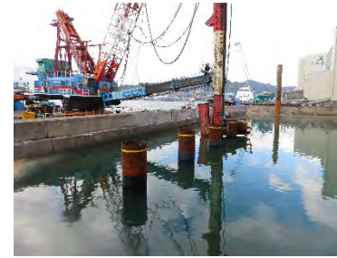
鋼管杭打設の様子
