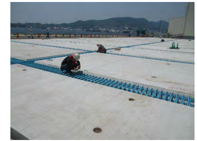
床版設置の様子
