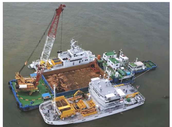
クレーン付台船を用いた回収作業事例 (29年度)
