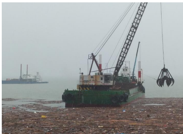
クレーン付台船等による漂流物の回収 (一般社団法人 日本埋立浚渫協会 九州支部) (九州港湾空港建設協会連合会)
