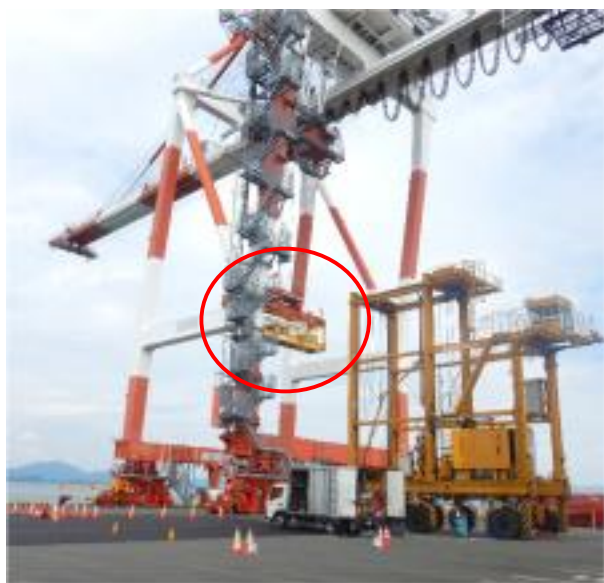
コンテナと同等の重量を持つおもりを吊り上げる ガントリークレーン
