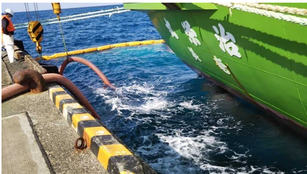
サンドポンプ軽石除去状況
