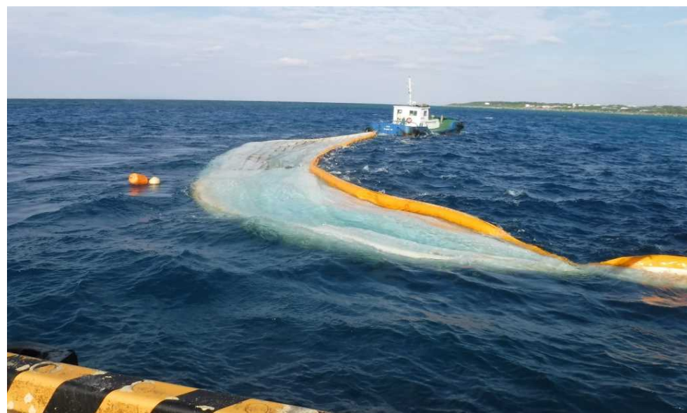
着火船によるシルプロの開口作業
