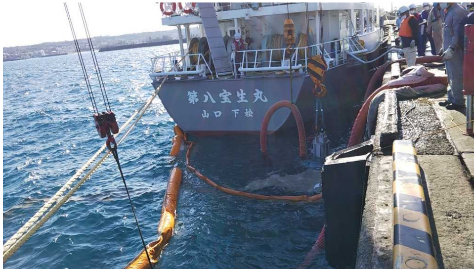
サンドポンプ軽石除去状況
