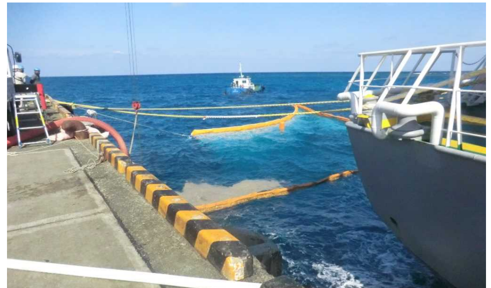
着火船によるシルプロの開口作業
