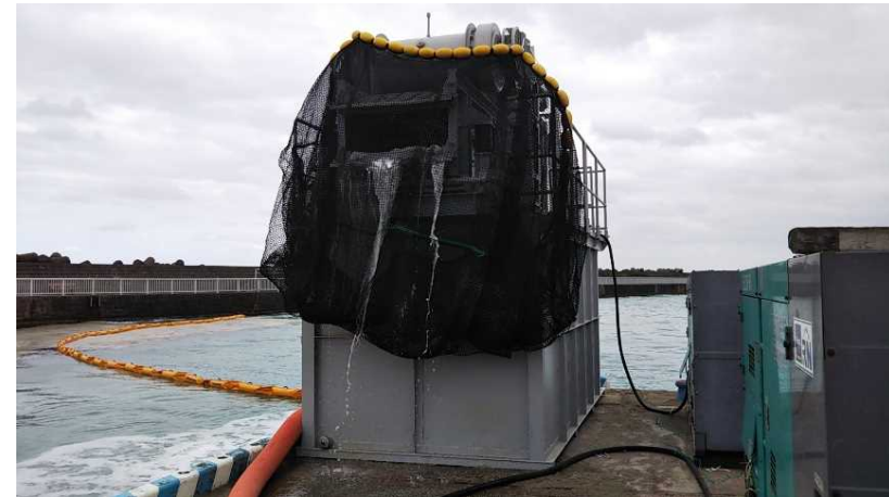
土砂受入状況
