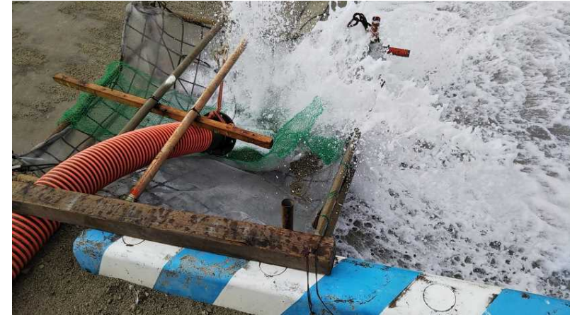
土砂受入状況
