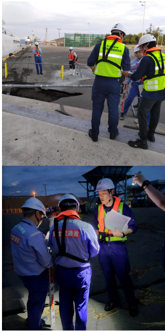
研究所TEC(国総研、港空研) 現地調査状況
