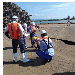
被害状況調査
