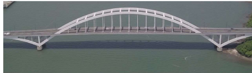
図-1 施工箇所写真
