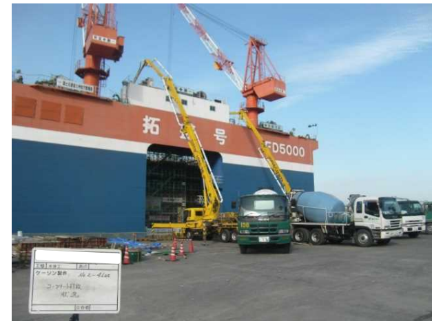
③コンクリート打設はポンプ車にて行います。
