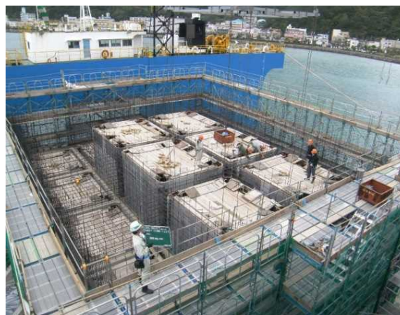
②コンクリートを入れる型枠を組み立てます。
