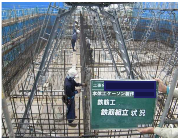
①縦横決まった間隔で鉄筋を組み立てます。
