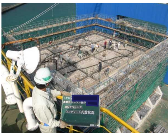
コンクリート打設
