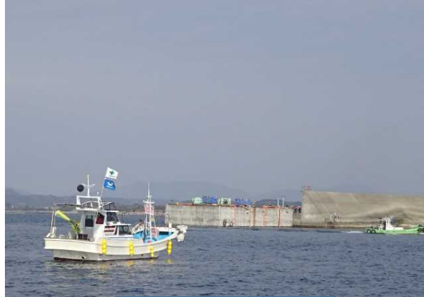
②ケーソン据付
