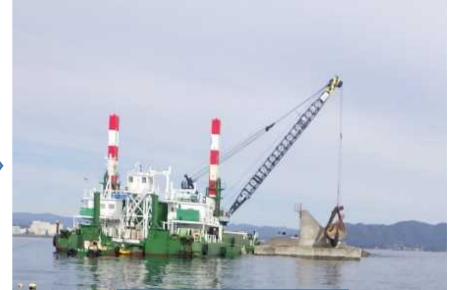
③ケーソン中詰め
