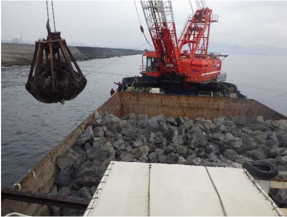
①基礎捨石投入
