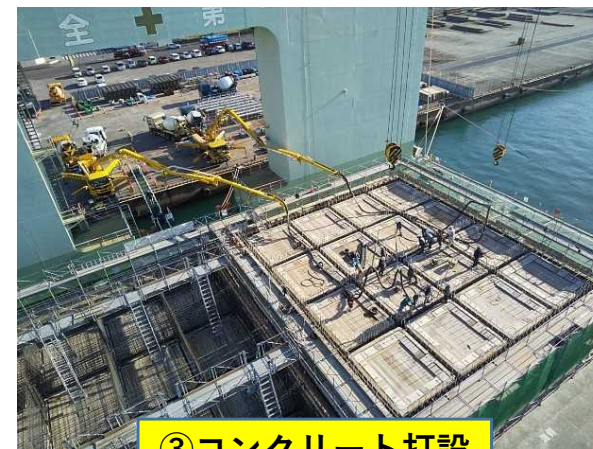
③コンクリート打設
