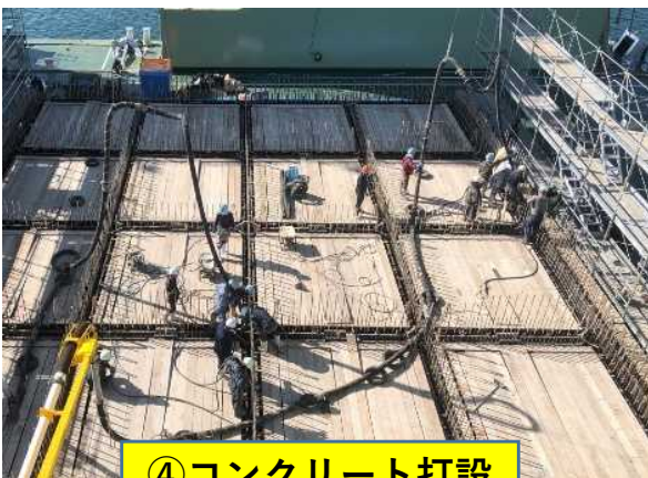
④コンクリート打設
