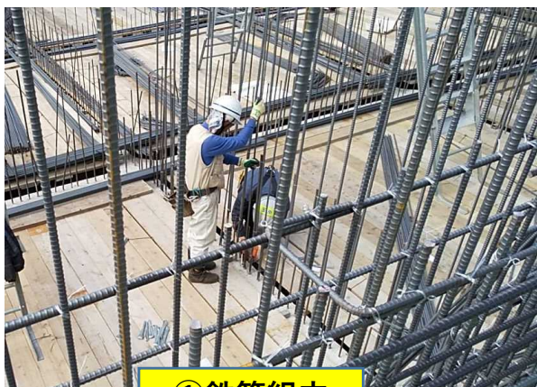
①鉄筋組立
