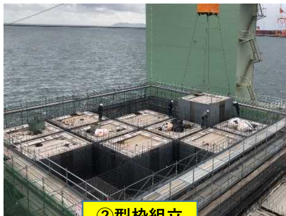
②型枠組立
