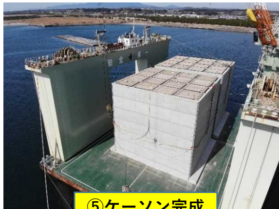
⑤ケーソン完成
