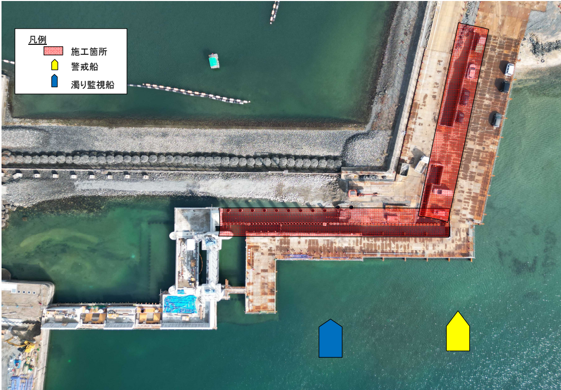
図-1 工事実施箇所(新川水門)
