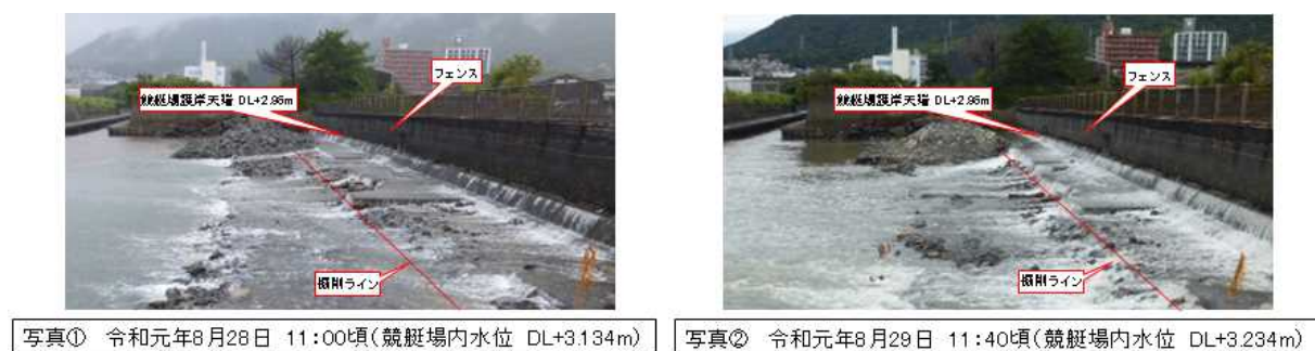
図 3 - 2 - 2 被災前後における競艇場内水位の越流状況
