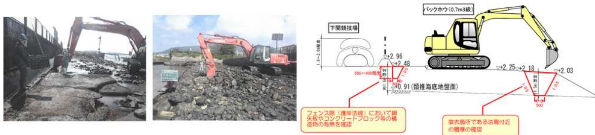
図2-4-2：試掘位置及び試掘写真
