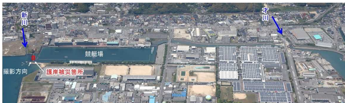
被災前の状況
