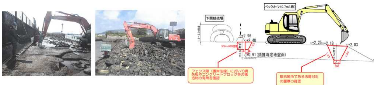
図2-4-2 試掘位置及び試掘状況
