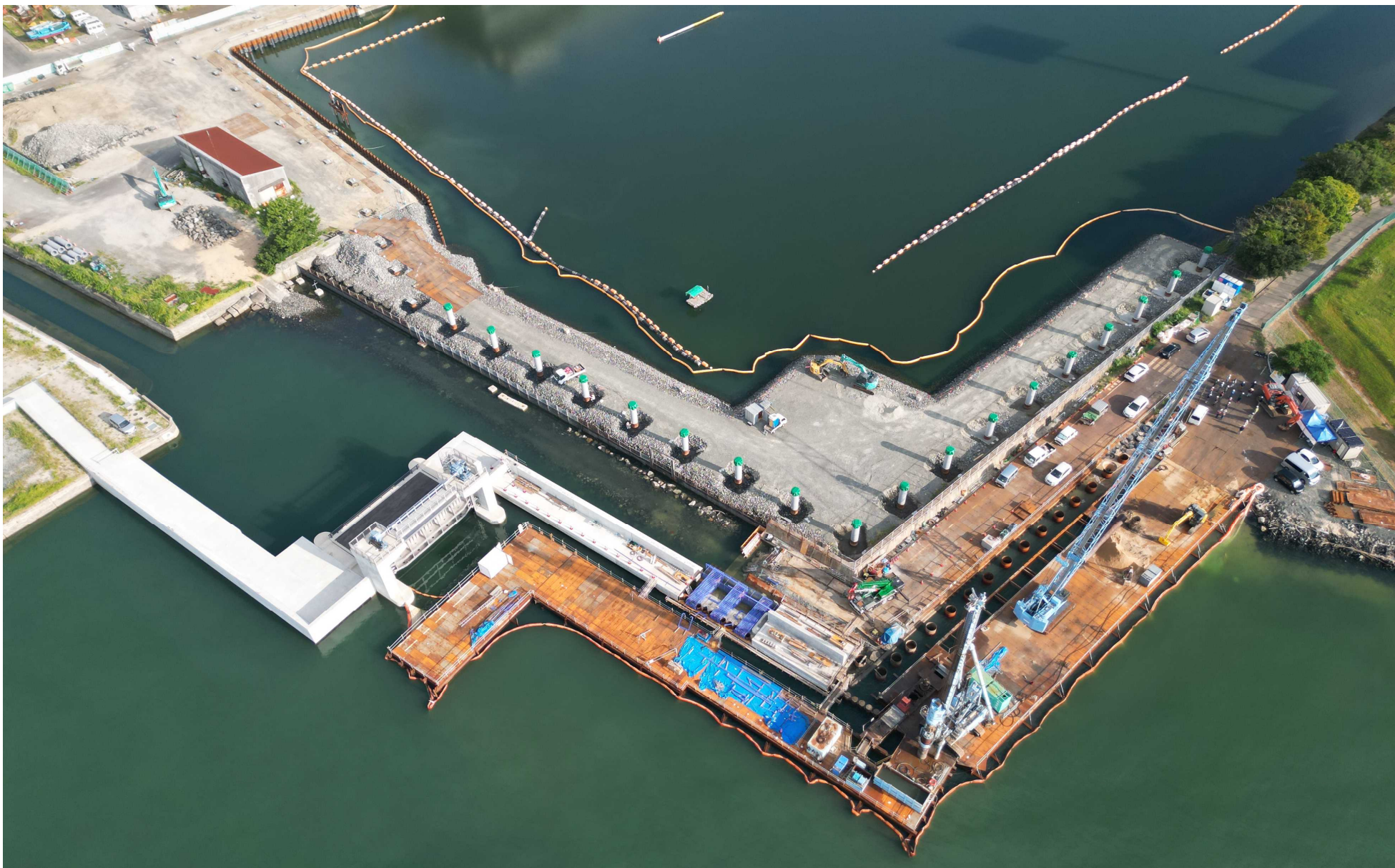
下関港海岸 新川水門
