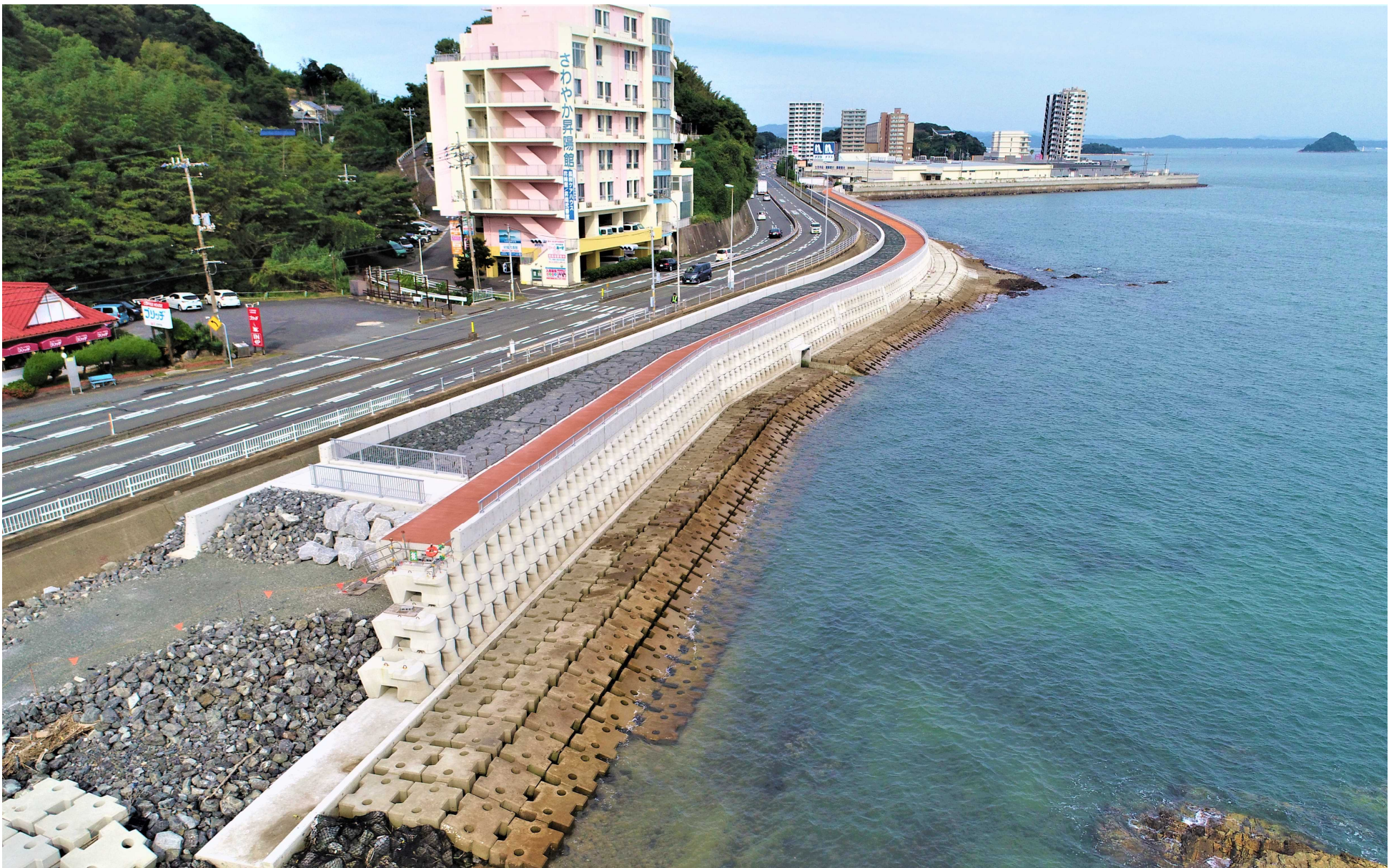
進捗する護岸工事(下関港海岸 黒門－黒門南地区)
