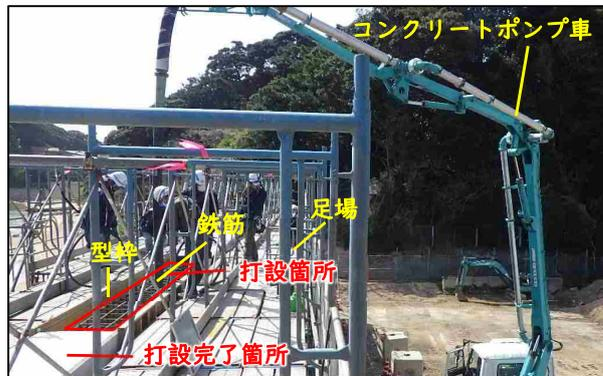
起重機船にてコンクリートを運びコンクリートポンプ車にてコンクリートを打設
