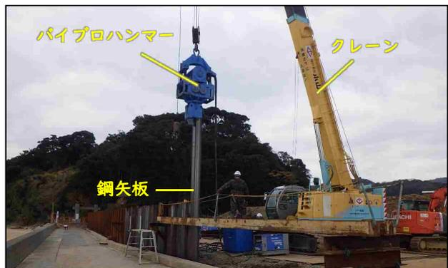
パイプロハンマーにて鋼矢板を打設
