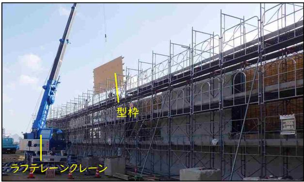
養生後、ラフテレーンクレーンを使用し、型枠を取り外す
