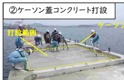
中詰材を人力で平らに均し、コンクリートポンプ車にて圧送したコンクリートを打設し、蓋(厚さ:20cm)をします。
