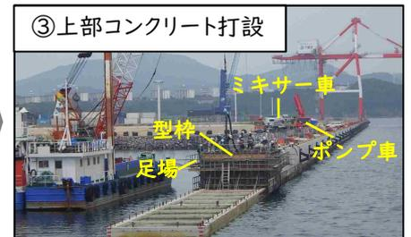
ケーソン周辺に足場(人が作業できる通路)と型枠(所定の形状にコンクリートを打ち込む枠組み)を設置し、コンクリートポンプ車にて圧送したコンクリートを打設します。
