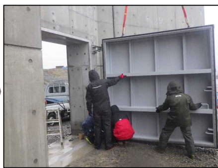
設置状況 （胸壁背後より、ラフタークレーンにて搬入）
