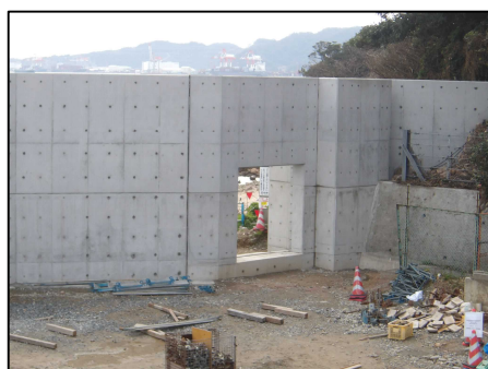
陸閘設置前 （堤内地側より撮影）
