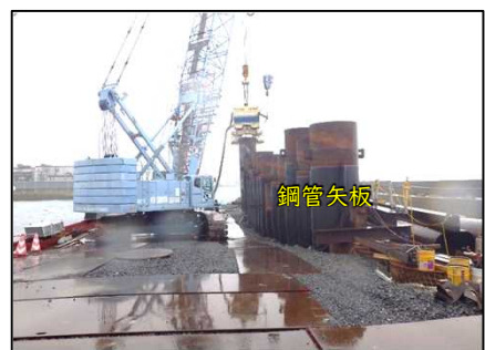
バイブロハンマによる鋼管矢板打設
