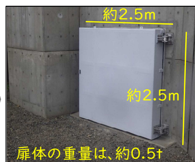
陸閘設置完了 （堤外地側より撮影）
