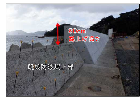
既設防波堤上部嵩上げ
