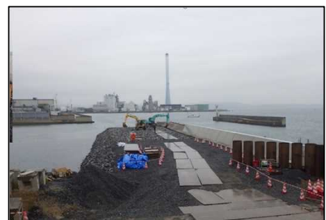
鋼管杭打設後の雑石整正状況
